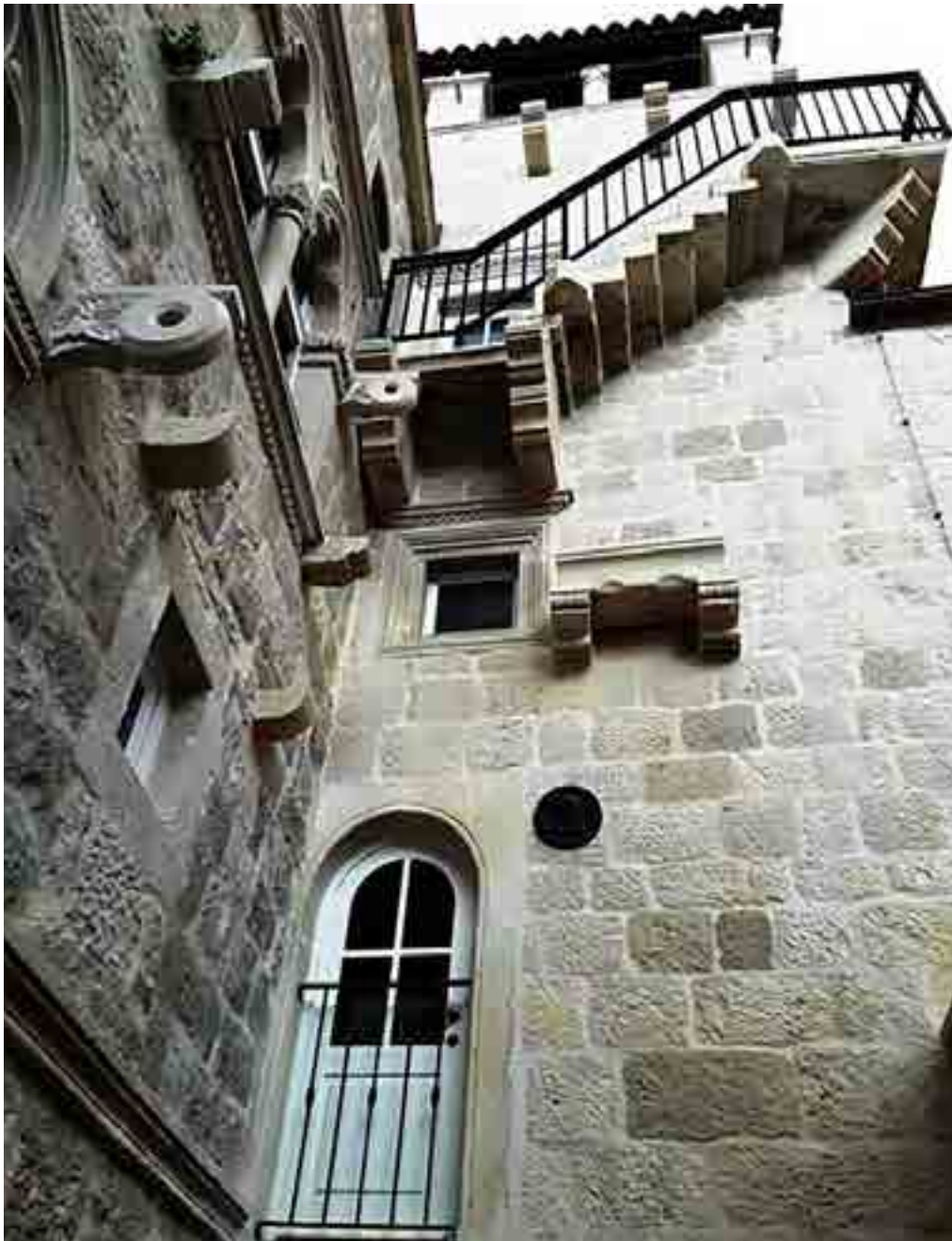
ΕΞΩΤΕΡΙΚΗ ΑΠΟΨΗ ΤΟΥ ΚΤΙΡΙΟΥ ΤΟΥ 17ΟΥ ΑΙ. ΠΟΥ Η ΠΟΛΗ ΥΠΟΣΤΗΡΙΖΕΙ ΟΤΙ ΧΤΙΣΤΗΚΕ ΣΤΑ ΕΡΕΙΠΙΑ ΤΟΥ ΣΠΙΤΙΟΥ ΤΟΥ (КУСА МАРКА РОЛА)
